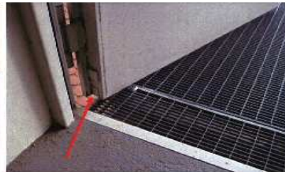
Einbau eine selbstdichtenden Dichtleiste
